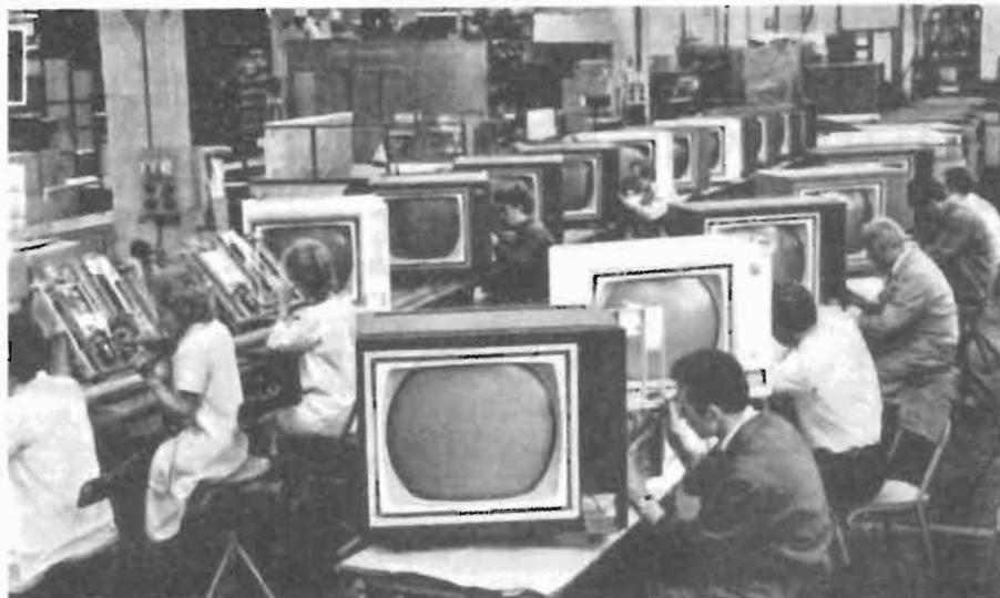
Montaggio e collaudo di televisori a colori SECAM presso la C.F.T.
